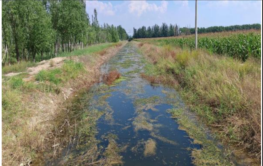
图 3-7 东一支沟前进电排站下游夏天现状图（出自《第三、五排平罗段水系连通工程初步设计报告》）
