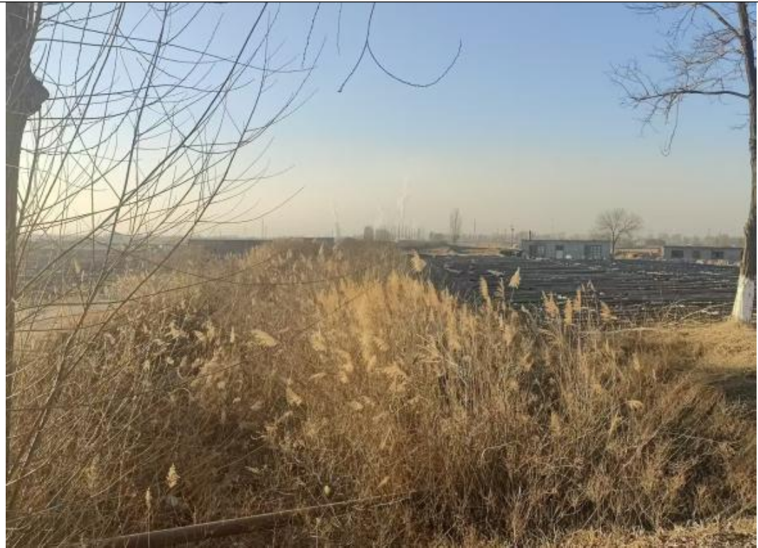
图 3-17 唐徕渠退水沟冬天现状图
