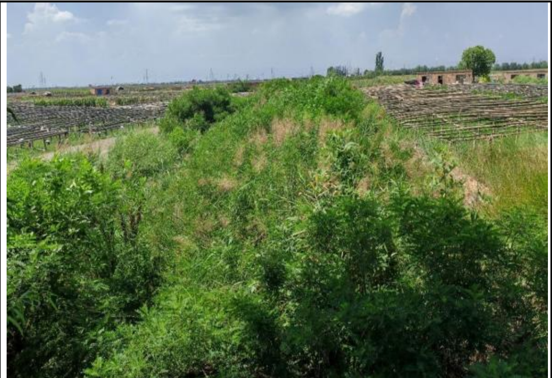
图 3-15 唐徕渠退水沟夏天现状图（出自《第三、五排平罗段水系连通工程初步设计报告》）
