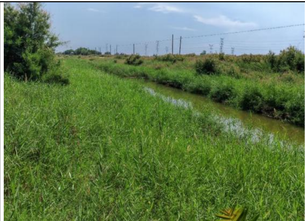
图 3-3 第三排水沟 25+810 处夏天现状图（出自《第三、五排平罗段水系连通工程初步设计报告》）
