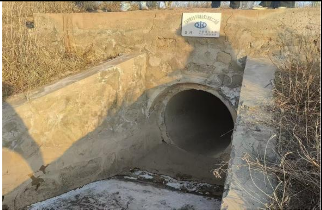
图 3-18 唐徕渠退水沟入三排尾水冬天现状图
