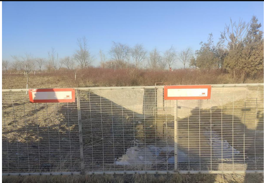
图 3-12 东一支沟入康家湖涵洞进口冬天现状图
